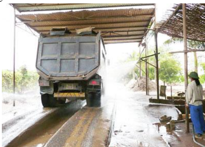
Hình 6. Hình minh họa phun rửa bánh xe tại dự án
